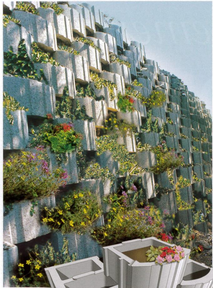
Son principe de caissons superposés est idéal pour les rosiers, plantes aromatiques, plantes rampantes ou rampantes. Il est possible de prévoir l'intégration d'un système d'arrosage automatique.
